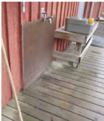
Veden roiskesuojausten tarkistusta
