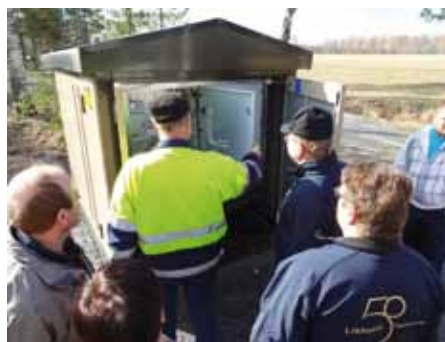
Turvakävelykohteisiin kuului myös sähkölaitteiden tarkastus
