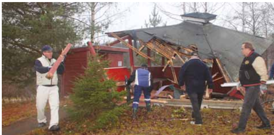
Ilpo lankunkantopuuhiissa Maisan vanhaa grillikatosta purettaessa viime syksynä.
