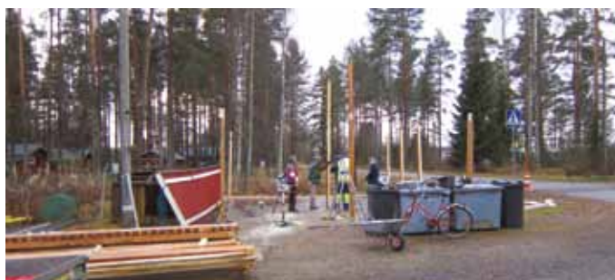
Jätteiden kierrätyspisteen rakennustyö alkaa
