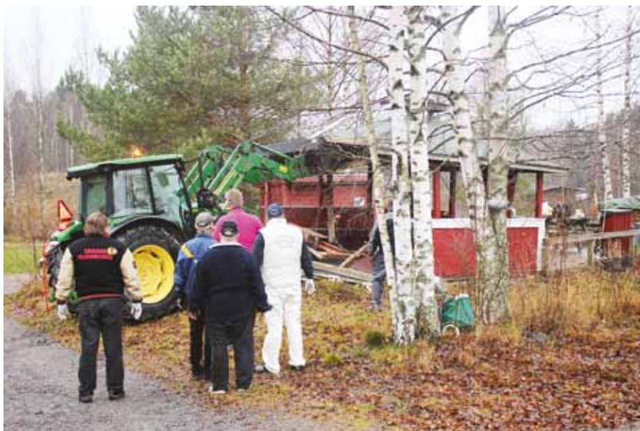
Mikä onkaan miestenpäivälle parempaa puuhaa, kun päästä purkamaan vanhaa grillikatosta.
