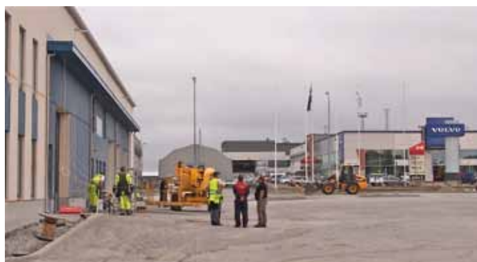
Pirkanmaan Autotaidon uusi AD-korjaamo sijaitsee Tampereen auto-, varaosa- ja huoltokeskittymässä Lokomonttiellä Hatanpään itäpuolisella alueella
