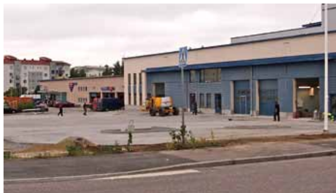
Uusi huolto- ja korjaamotila on kooltaan n. 700 m 2 ja maalaamo n. 300 m 2
