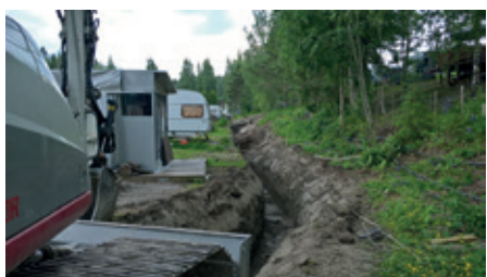
Sähkökaapelia maan alle
