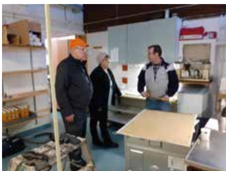
Pubi ja keittiöremontti alkuvaiheissaan
