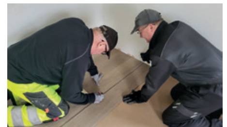
Nuorisotilan lattiapinnan laitossa Upi ja Jari
