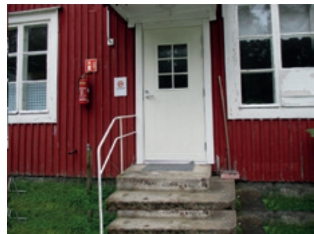
Huvikummun päätyihin asennettiin uudet ovet
