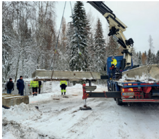
Oli meillä siilon rakentamisessa tosin sitten vielä järeämpiäkin teknisiä apuvoimiakin ja kyllä nousi.
