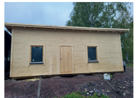
Se on siinä. Maalia pintaan, kate kattoon ja sitten sisätyöt
